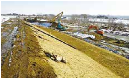
散布後、pH7.5～8.0で安定。 野芝を張り付け。(2013年1～3月)
