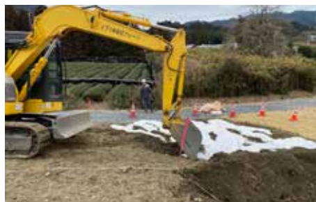
バックホウ混合（小規模）
