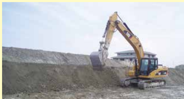
曝気養生：バックホウで土壌を天地返しする要領で空気と接触させます。
