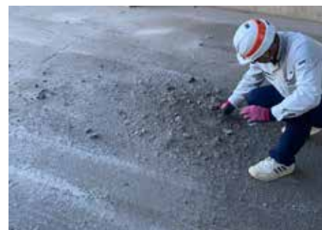
③焼却灰の清掃（発電所）
