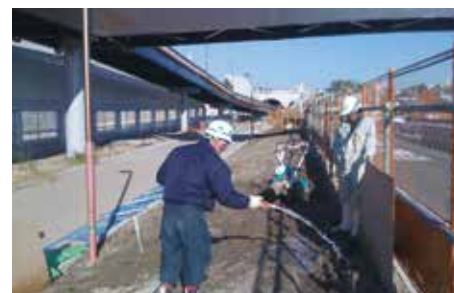
道路緑地帯への散布と養生（アスファルトの白濁防止）
