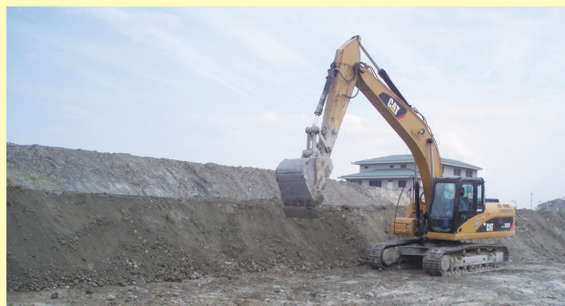
曝気養生：バックホウで土壌を天地返しの要領で空気と接触させます。
