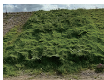
施工後 6 か月経過
