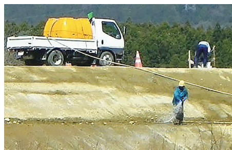
タンクと動力噴射機をトラックに積載して希釈液を作成し法面に散布
