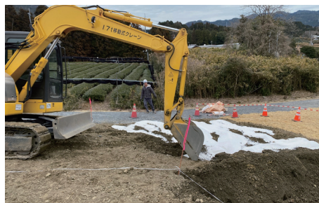
バックホウ混合（小規模）
