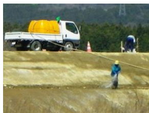
法面(河川堤防)への散布。 pH10 に対し 12 倍希釈液を 2 リットル/m 2 散布
